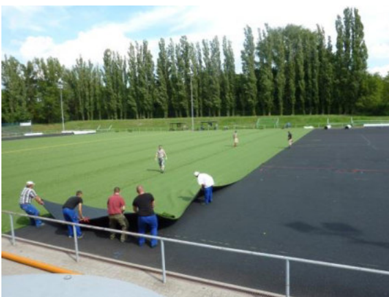
Fußballplatz Ollenhauerstraße, Verlegung Kunstrasen
